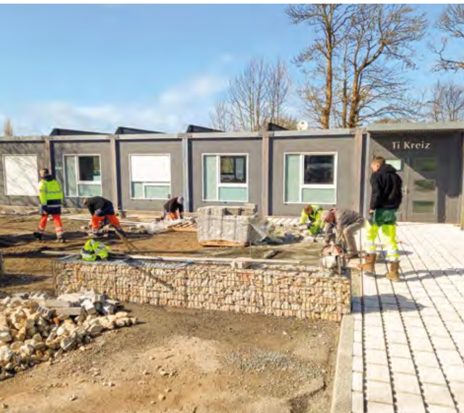
▲ Les abords de la salle Ti Kreis à Croas Spenn bénéficient actuellement d'un réaménagement dont les travaux sont réalisés par les agents des services techniques.
